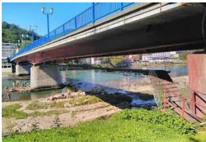
Slika 9: Most ispod mosta
